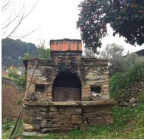
Şekil 4. Yerel Malzemelerle Yapılmış Sokak Fırını Örneği (Kaynak: Yazar Arşivi, 2020)
