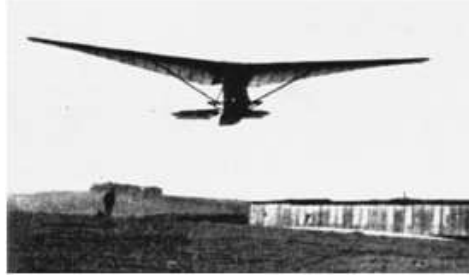
Şekil 9. Lippich'in insan gücü ile tahrik edilen ornithopteri [17].
