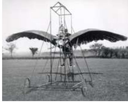
Şekil 8. Edward P. Frost'un içten yanmalı motorla tahrik ettiği ornithopter tasarımı [16]
