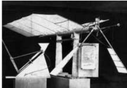
Şekil 7. Lawrence Hargrave'in Buharlı Motor Tahrikli Ornithopteri [10]
