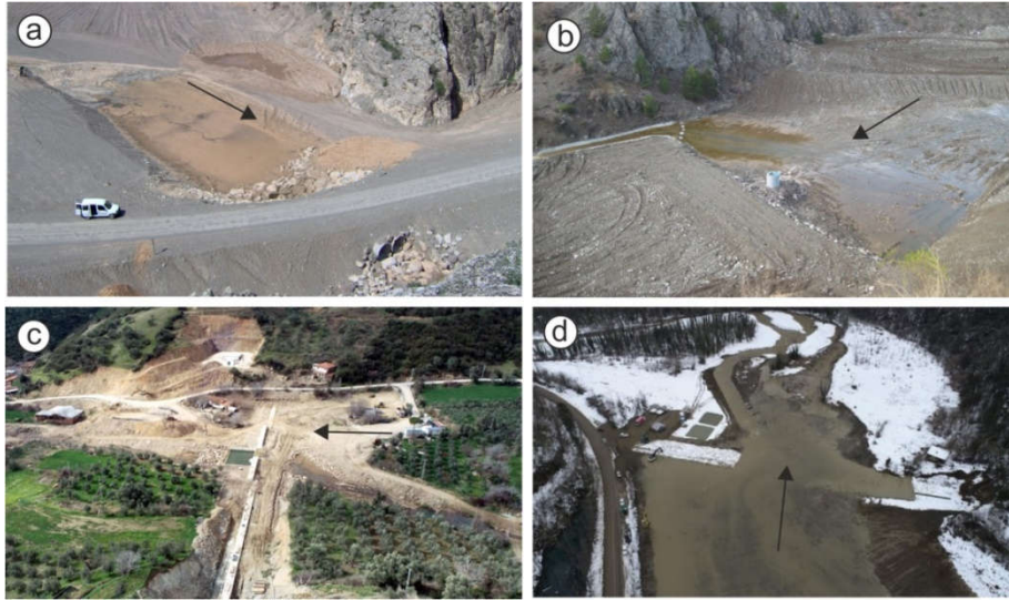
Şekil 1. Malıboğazı (a), İskilip (b), Kiraz (c) ve Bahçecik (d) yeraltı barajlarında yerüstündeki yapıların inşaat tamamlandıktan hemen sonraki görüntüleri. Oklar akış yönünü göstermektedir (foto a ve b, A.Apaydın, c ve d, www.dsi.gov.tr, erişim tarihi, 19 Mayıs 2022)
